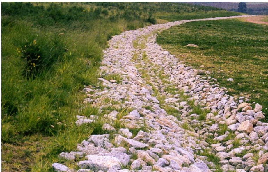
Figura 71. Circulación del agua a través de un canal revertido de caliza y construido en una escombrera restaurada.
