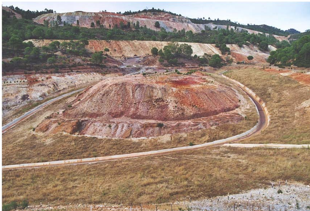
Figura 10. Remodelación de la superficie y colocado de cunetas perimetrales.
