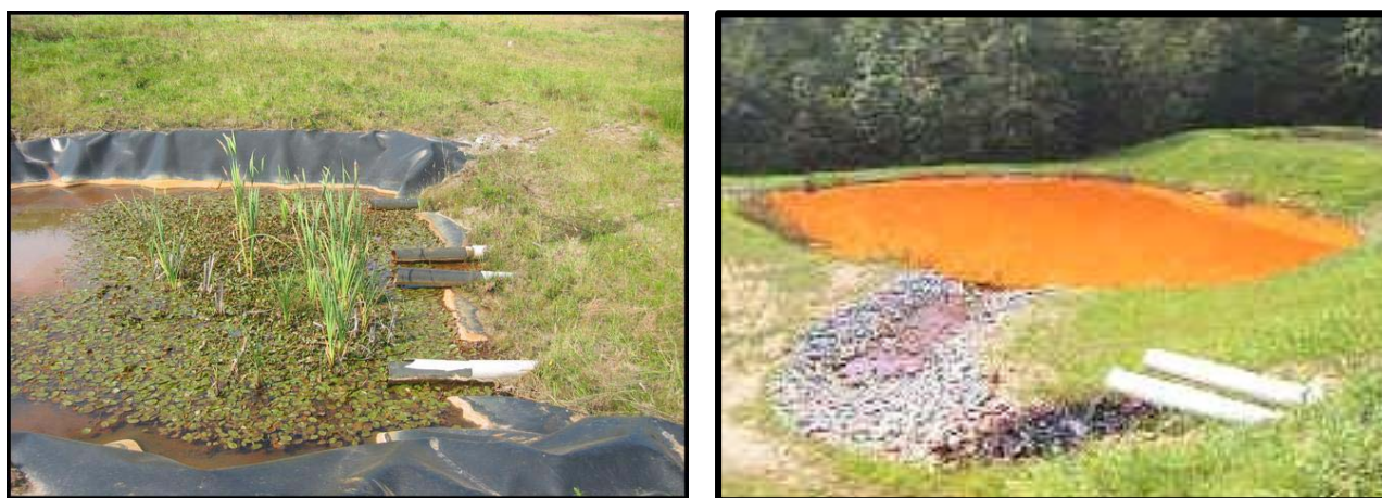
Figura 70. Balsas de oxidación y precipitación a la salida de un ALD.
