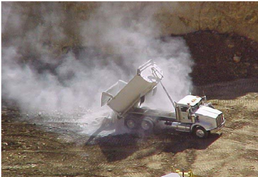
Figura 16. Adición de material alcalino.
