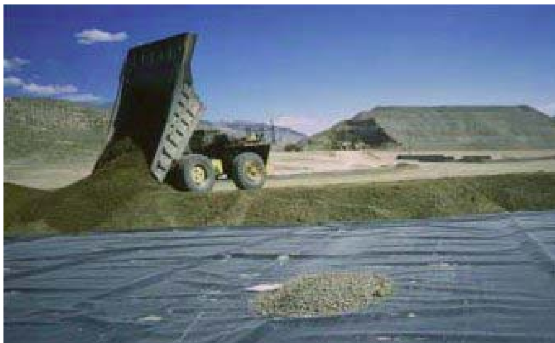
Figura 11. Sellado de superficies con láminas impermeables y suelo vegetal.
